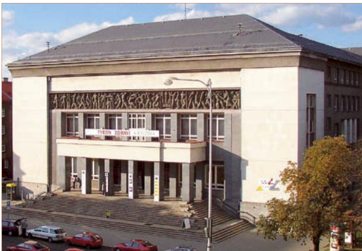
pohled na čelní fasádu Hornického domu – stav v roce 2004 (foto autor)
