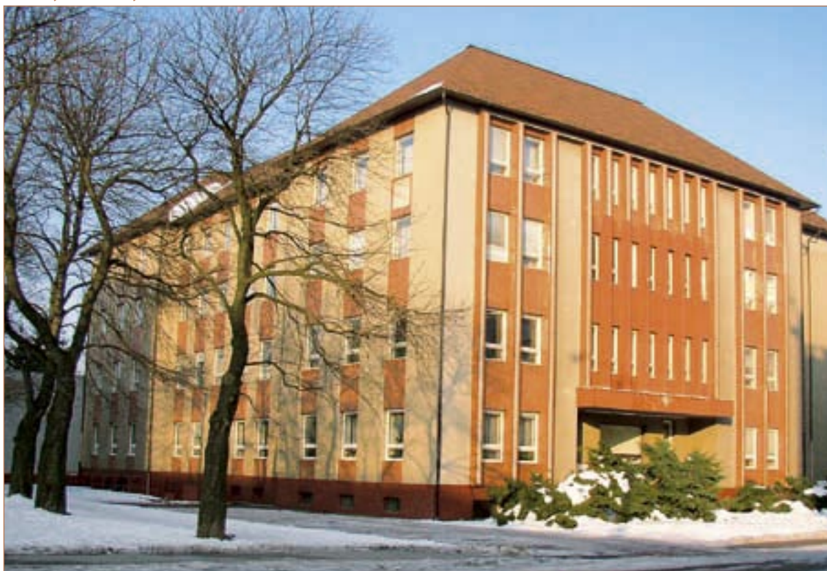
současný stav budovy z ledna 2005 (foto autor)
