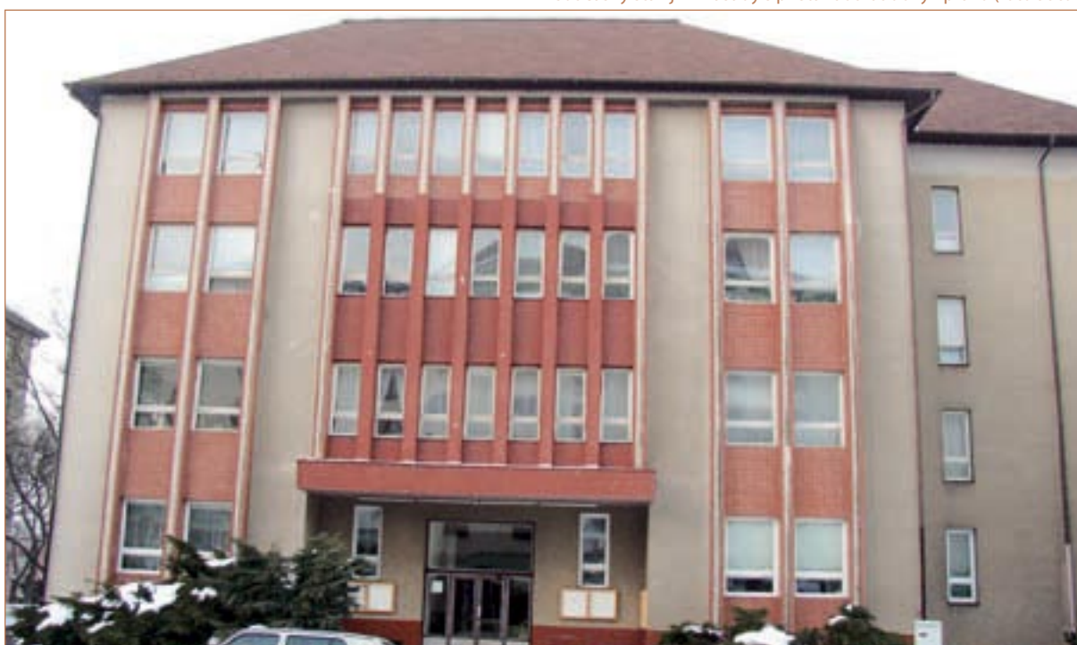
současný stav jižní fasády s přístavbou budovy vpravo (foto autor)
