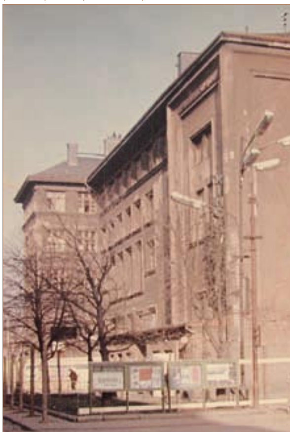
fasáda před rekonstrukcí v roce 1968 (SPA HDB, fond BS, krabice č. 15)
