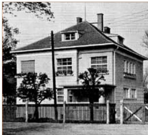
dům čp. 241 po dokončení (archiv autora)
