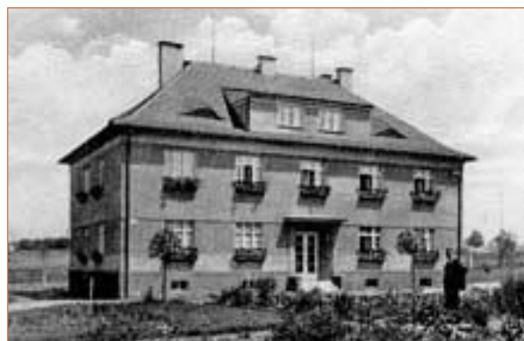
obytný dům v Dolním Rychnově čp. 249 (archiv autora)
