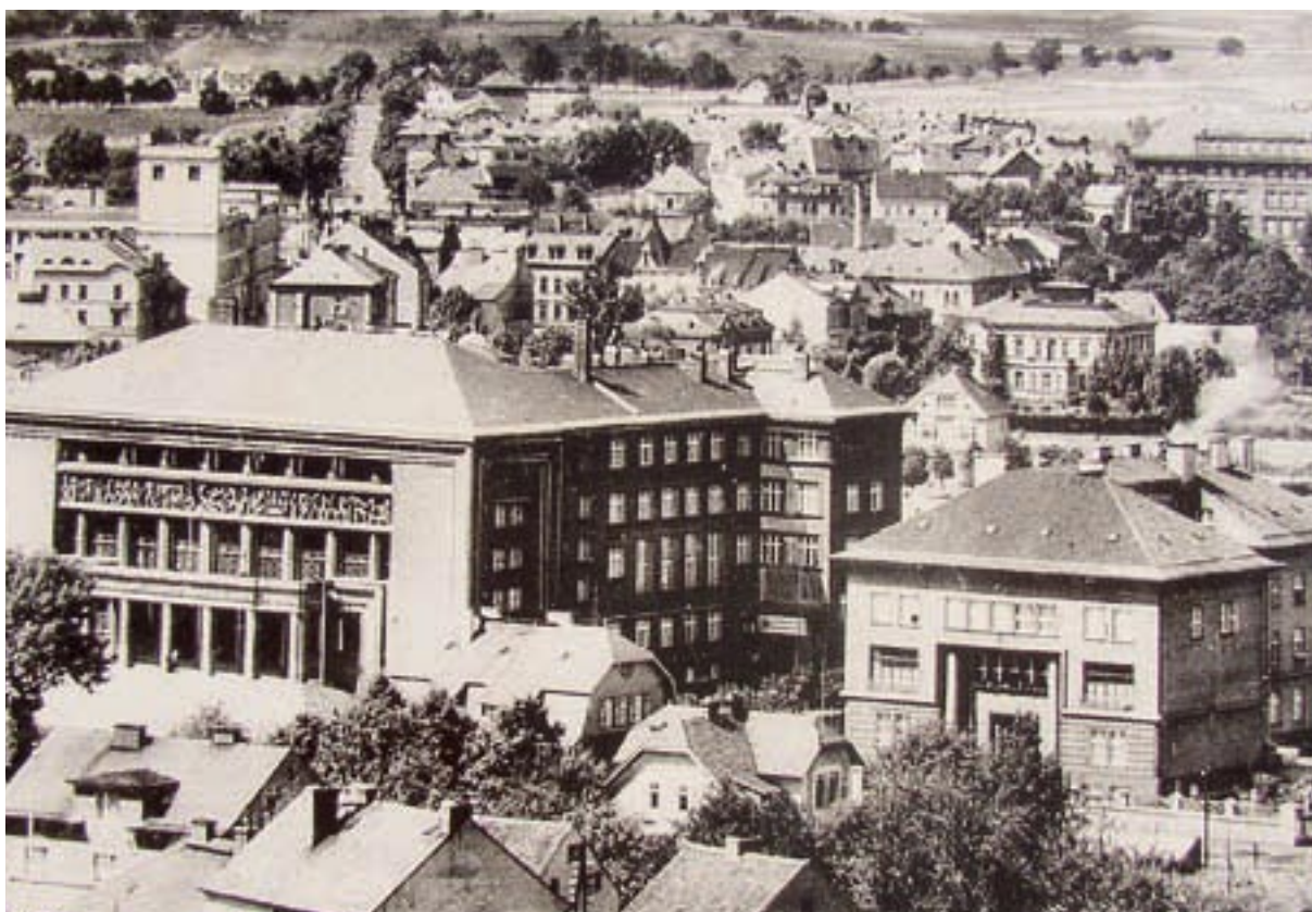
pohled na část Sokolova s Hornickým domem a Bratrskou pojišťovnu (pohlednice z archivu autora)
